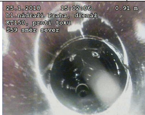
FOTO DR6: Shluk prasklin v horní části profilu
